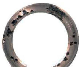
Corrosión por picadura
